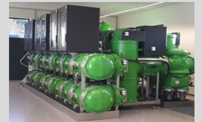
SF6-free switchgears
