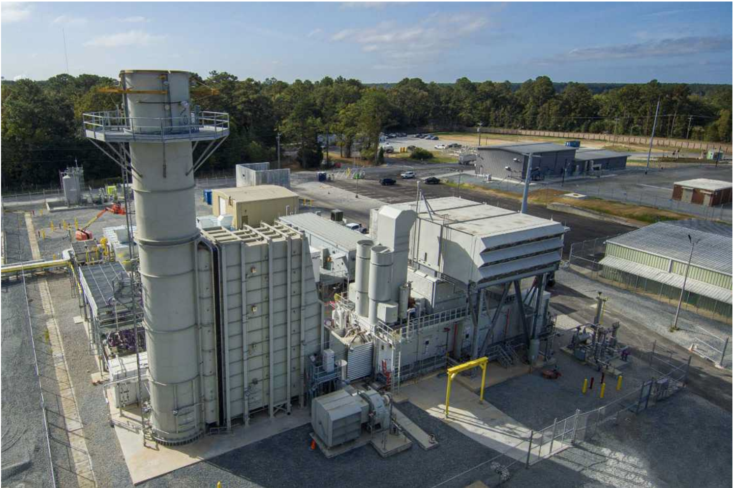
Hình 1: Máy phát điện tuabin khí LM6000* được thiết kế với khả năng bù đồng bộ.
