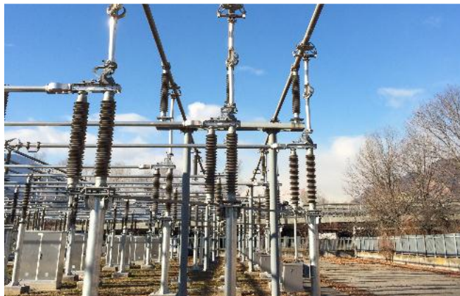
SPVL-Trennschalter mit angebaurem DWatch Antrieb
