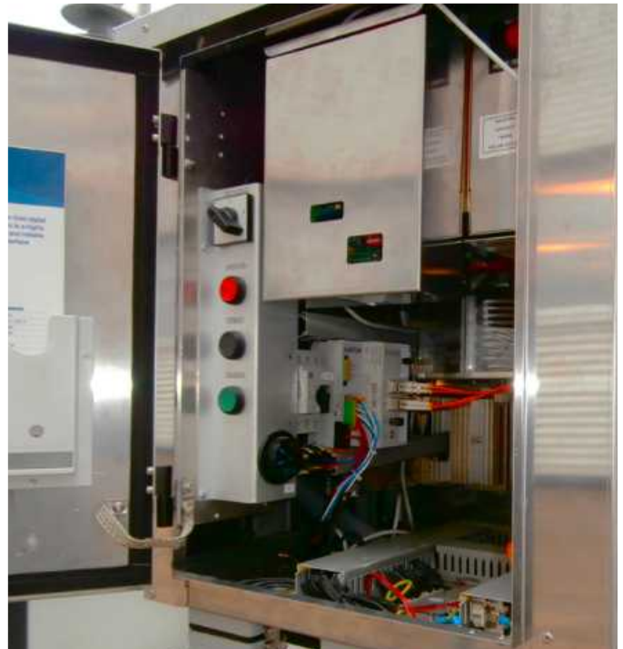
Mécanisme de commande du DWatch avec le proxy DWatch et l'option fibre optique
