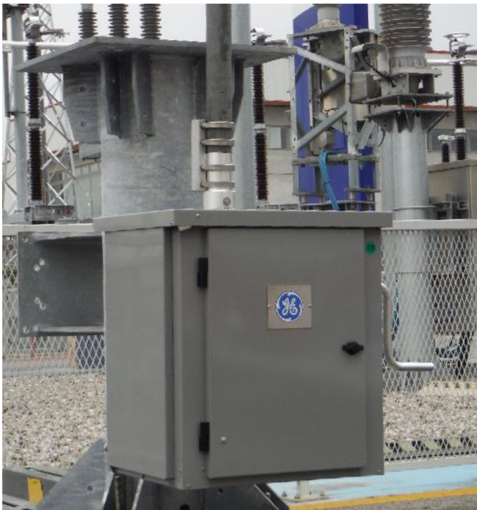
Installation type du mécanisme DWatch - vue externe
