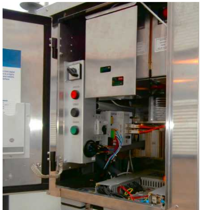
Mecanismo de accionamiento del DWatch con el proxy DWatch y la opción de fibra óptica
