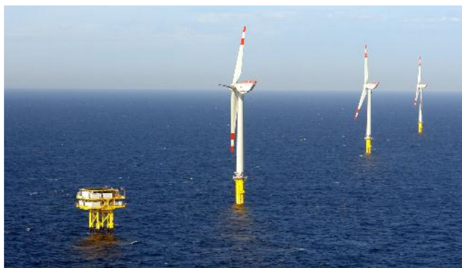
75 MVA 115/31 kV Hermetiktransformator mit Vakuum-Laststufenschalter und Online-Überwachungssystem MS3000 für den Offshore-Windpark Alpha Ventus. In Betrieb seit 2008
