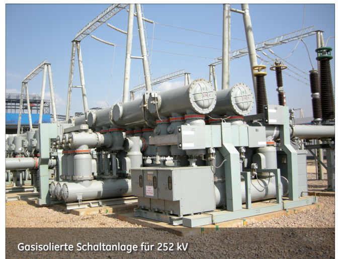
Gasisolierte Schaltanlage für 252 kV
