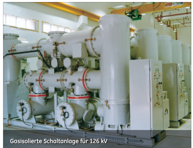
Gasolierte Schaltanlage für 126 kV
