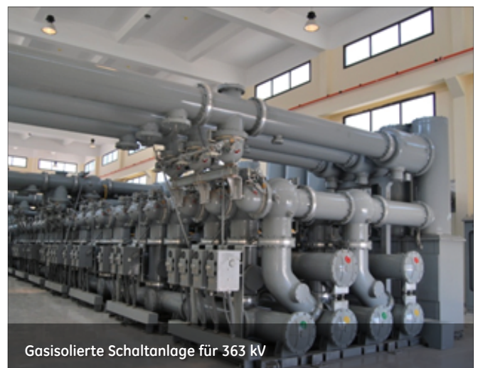
Gasisolierte Schaltanlage für 363 kV am Umspannwerk Golmud
