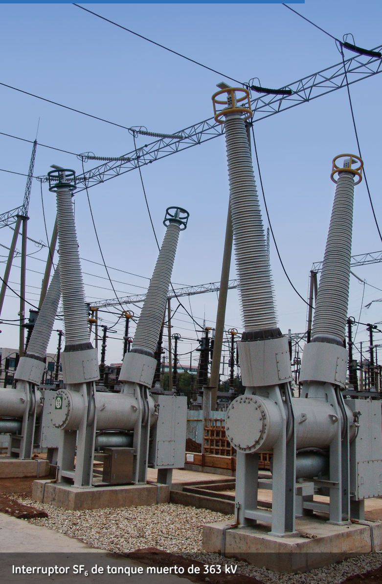
Interruptor SF 6 de tanque muerto de 800 kV
