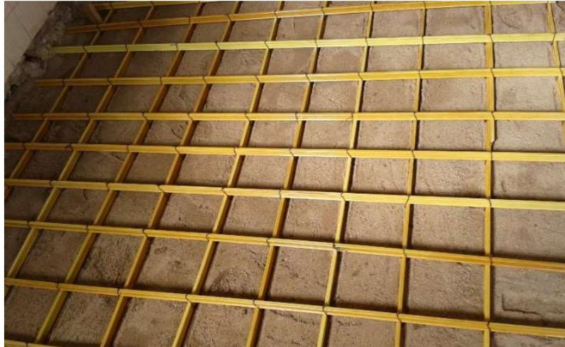
Figura 7: Reforço da fundação utilizando material não metálico (fibra de vidro)
